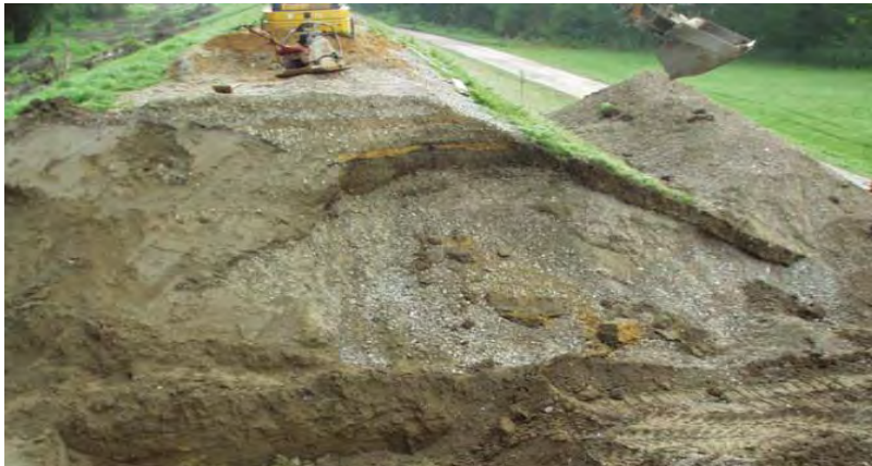
Flussdeich an der Donau bei Vohburg (Lkr. Pfaffenhofen a.d.Ilm ) Baujahr um 1890, verstärkt und erhöht 1956
